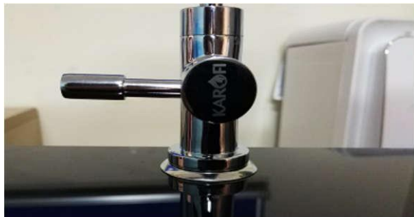
1. Lắp đặt vòi lên mặt tủ
