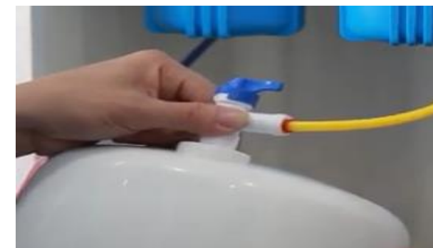
6. Lắp dây chống nổ bình áp
