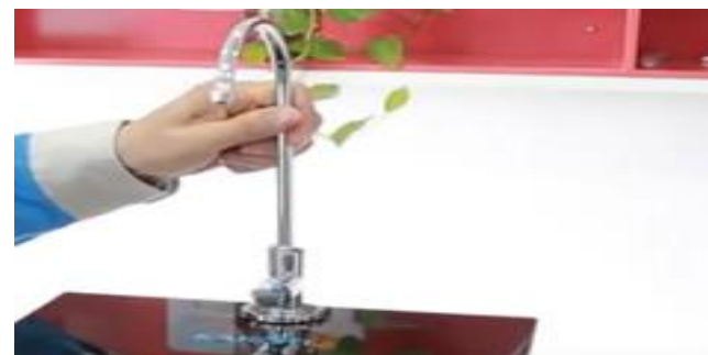
5. Lắp đặt cổ vòi
