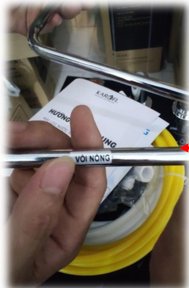
Bước 3 : Lắp đặt vòi nóng, lạnh
