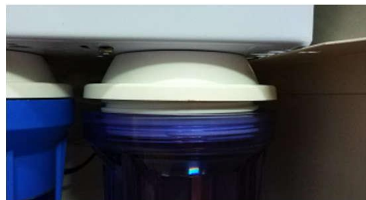
2. Mở lỏng cốc số 1 & mở nước từ từ xả air
