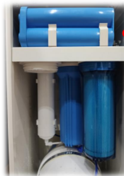
Bước 5 : Lắp lõi 1&2, không lắp cốc 3, xả rửa riêng lõi than số 2 (5 phút)
