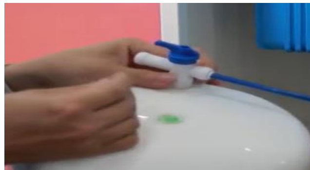
5. Lắp dây nước tinh khiết và van
