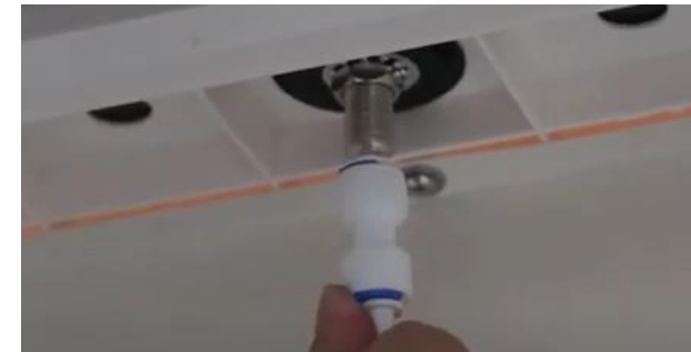
3. Lắp đặt dây dẫn nước lên vòi
