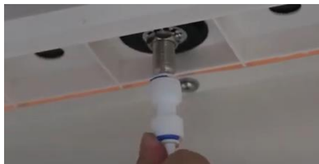
4. Lắp đặt dây dẫn nước lên vòi
