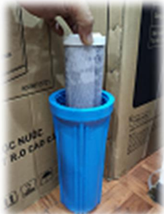
Bước 4 : Bóc vỏ nilong và lắp đặt các lõi lọc thô
