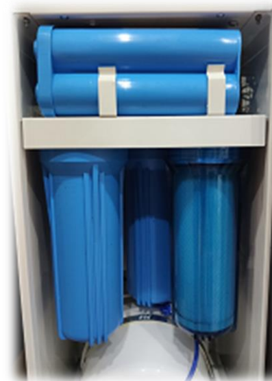
Bước 6 : Lắp lõi lọc cốc số 3 và vặn chặt cả 3 cốc lọc
