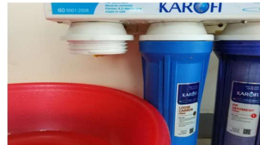
3. Xả sạch bụi than ở lõi số 2 sau đó mới lắp lõi số 3
