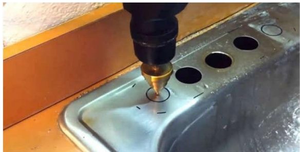
1. Thi công khoan đục + lỗ bắt vòi : Ø 16 mm
