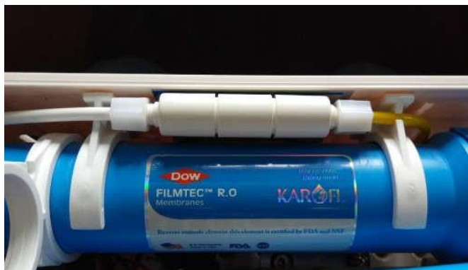
4. Lắp đặt đường dây nước thải và xả rửa màng RO
