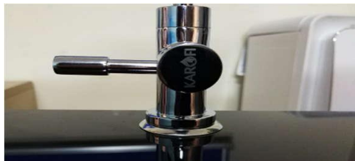
2. Lắp đặt vòi lên mặt tủ
